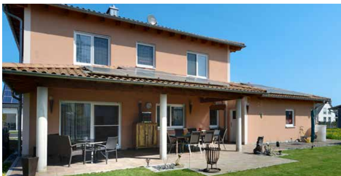
Förderung von Eigenwohnraum: Neubau eines Einfamilienhauses in Dillingen a. d. Donau; Fotograf: INCREON.
