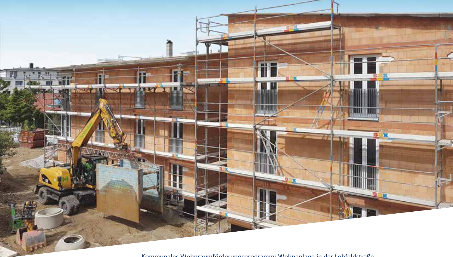
Kommunales Wohnraumförderungsprogramm: Wohnanlage in der Lohfeldstraße in Krailling. Bauherr und Bildrechte: Verband Wohnen im Kreis Starnberg.
