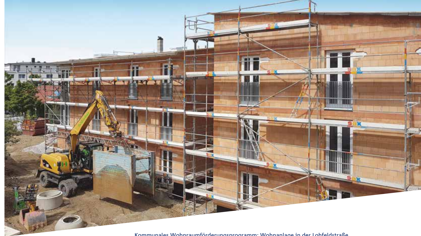
Kommunales Wohnraumförderungsprogramm: Wohnanlage in der Lohfeldstraße in Krailing. Bauherr und Bildrechte: Verband Wohnen im Kreis Starnberg.
