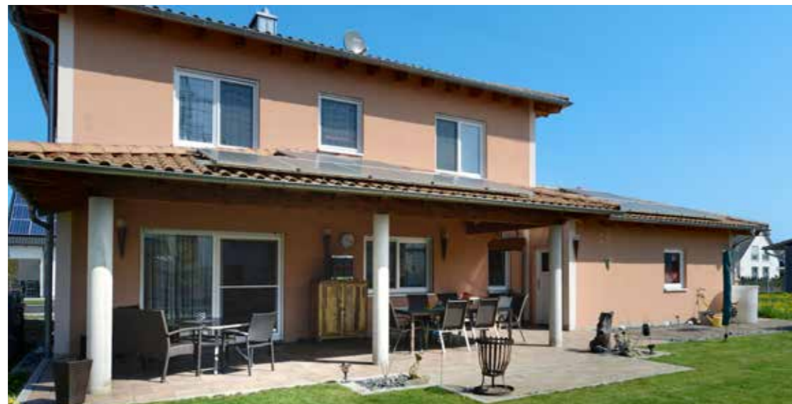
Förderung von Eigenwohnraum: Neubau eines Einfamilienhauses in Dillingen a. d. Donau; Fotograf: INCREON.
