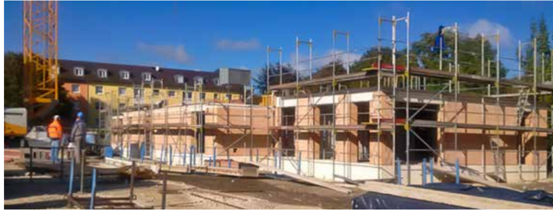
Wohnprojekt, Münsterblickstraße, Neu-Ulm, Bauherr: Stadt Neu-Ulm, Planer: Nething, Generalplaner
