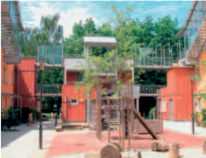
Nürnberg-Langwasser, Striegauer Straße. Architekten: Fritsch, Knodt, Klug, Nürnberg
